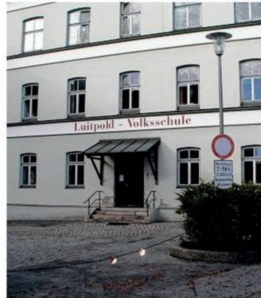
Mit der Sanierung der Hofbergschule soll auch der alte Schriftzug aktualisiert werden. FOTO GILG
